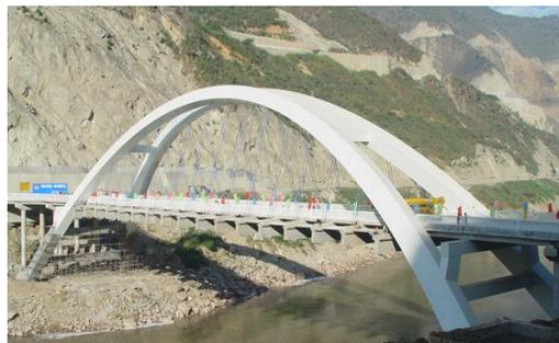
中承式拱桥（混凝土桥）
